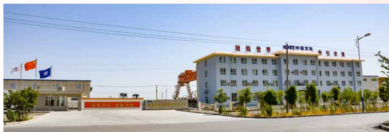
◎ 2011年10月28日，在新疆哈密建立了第二个风电塔筒生产制造基地，成立了新疆北车能源装备有限公司。
