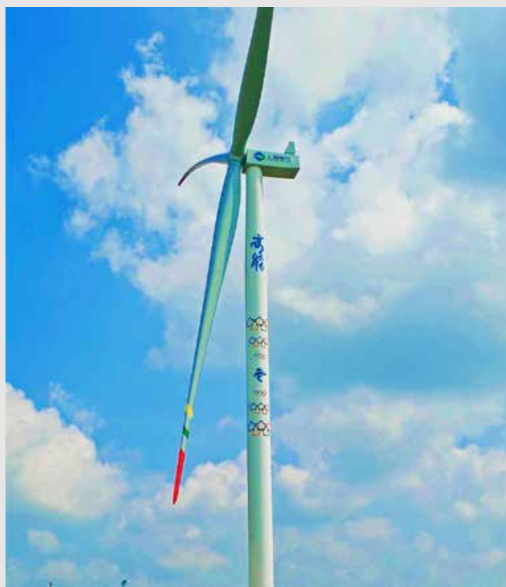
◎ 2021年5月，华北分公司制造的200MW风电塔筒，完成应景定制彩绘，助力2022北京冬奥会。
