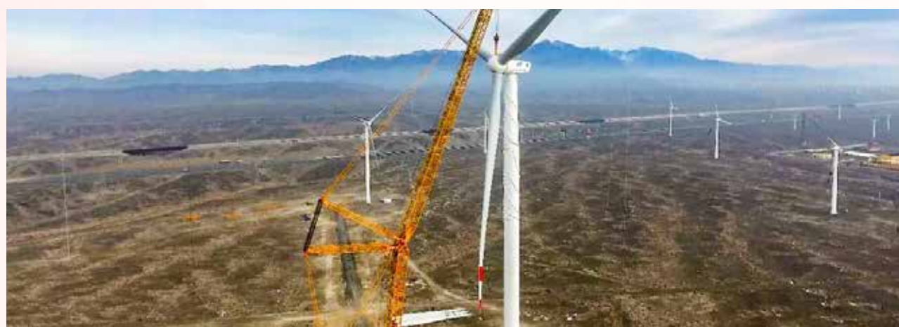
◎ 2018年1月，新疆公司制造的2.5MW风电塔架 Double140，叶轮直径140米，塔架高度140米。
