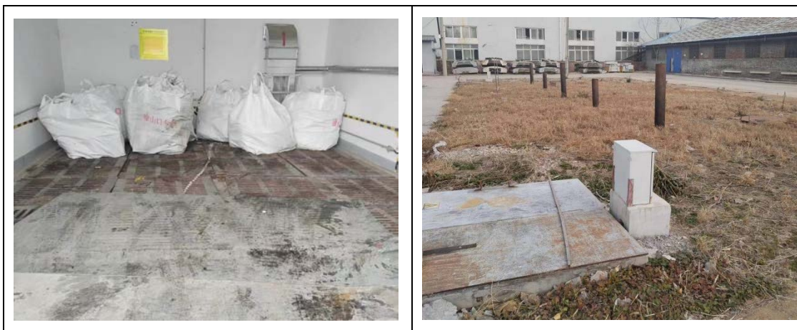
图 4-16 应急收集设施
