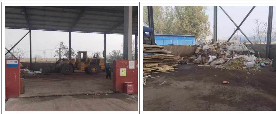
图 4-17 一般固废储存区
